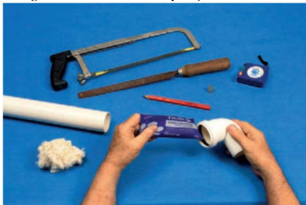
Figura 9. Encaixe do anel e aplicação do lubrificante
