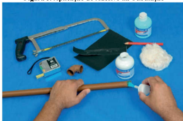
Figura 5. Aplicação do Adesivo na Tubulação
