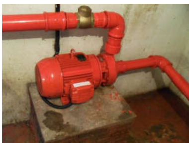
Figura 12. Bomba de incêndio
